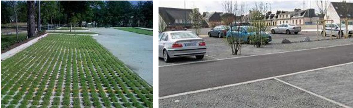
*Exemples de revêtements perméables pour le stationnement - Photos 1 et 2 : Espace de stationnement de la gare de Grissoles (31) (Source : CAUE de Haute-Garonne) – Photos 2 et 3 : Utilisation de revêtements perméables pour les espaces publics et stationnements*
